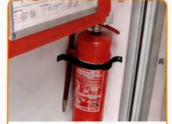
QH5601 – Yangın Tüpü Sabitleme Elemanı / Deprem vb. Sebeplerle Devrilmemesi İçin
